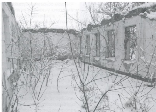
Разрушенное здание школы
